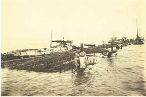
堤防を築くための潮止め工事 (岡山県立興陽高等学校所蔵)
